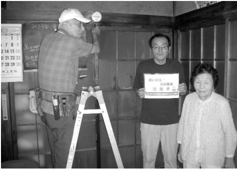
民生委員さんの立ち合いのもと、住宅用火災警報器を取り付けました。
